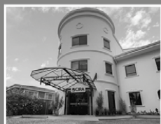
Centro Integral de Rehabilitación Asunción (CIRA)
